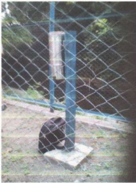
Gambar L2.2. Kondisi fondasi PCH Gemawang
