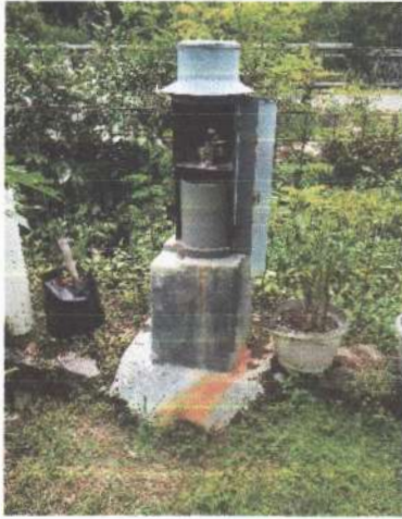
Posisi alat tegak dan fondasi rusak ringan
